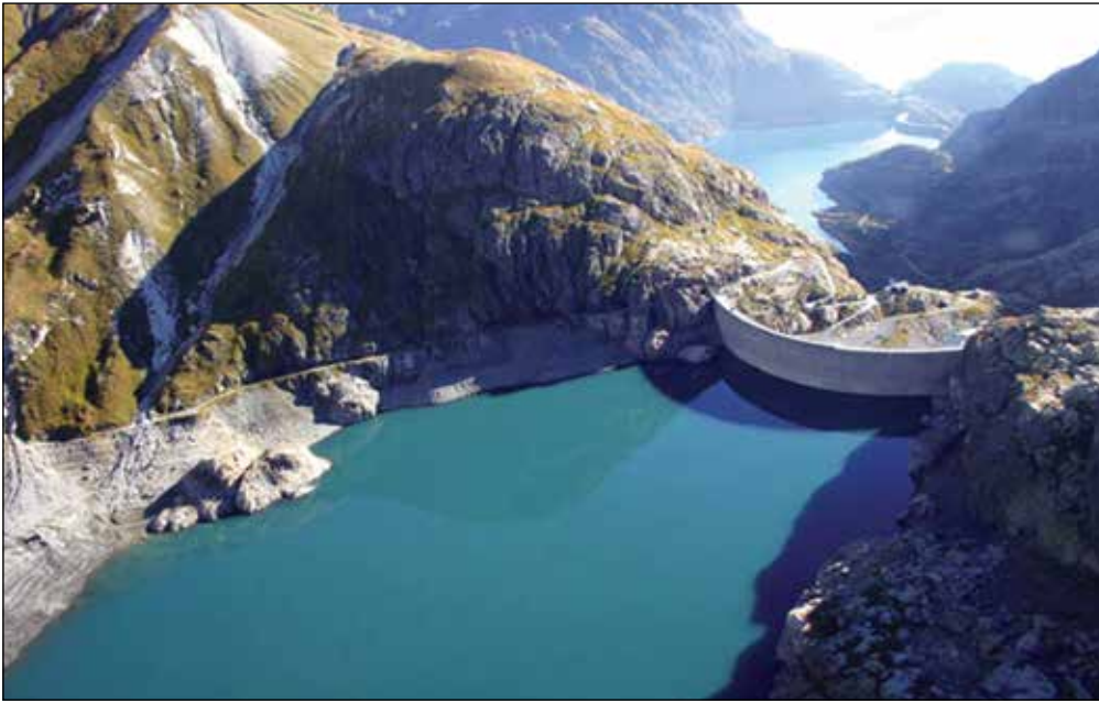
Figure 1 : Aménagement d'une STEP entre deux barrages de retenue dans le canton suisse du valais. Crédit photo : Nant de drance 2013.
