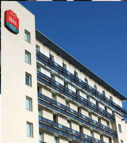
Brise-soleil et garde-corps
